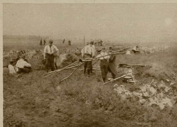
ÉDIFICATION D'UN ABRI POUR MITRAILLEUSE
