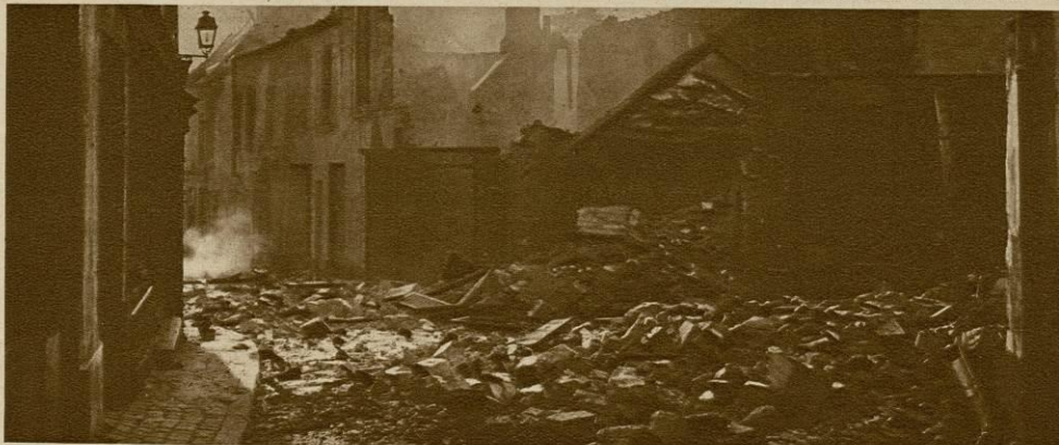
LA RUE BELLON ENTIÈREMENT ENCOMBRÉE PAR LES VESTIGES DE L'INCENDIE
