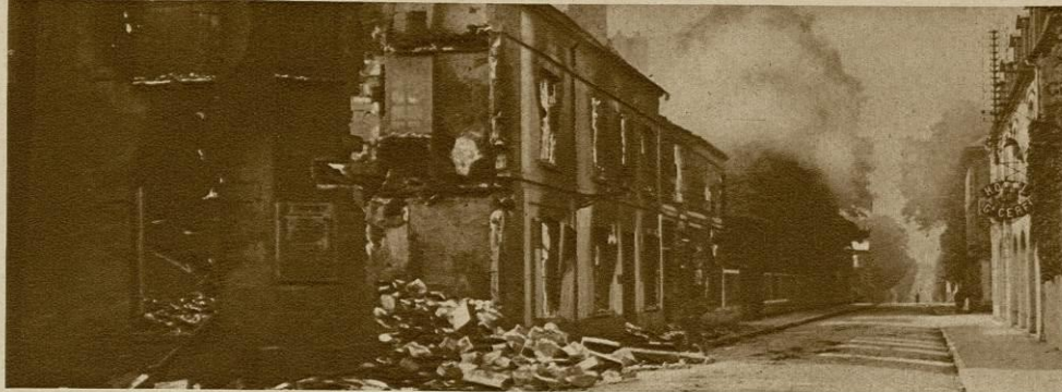
TROIS MAISONS ÉVENTRÉES ET DONT LES MURAILLES SONT ENCORE FUMANTES
