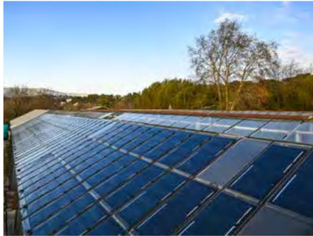
Des panneaux photovoltaïques ont été posés sur les vitrages des serres municipales, qui présentent une surface intéressante pour ce type d'installation. La production photovoltaïque en autoconsommation individuelle bénéficiera aux équipements des serres, et le surplus sera injecté sur le réseau public de distribution.
